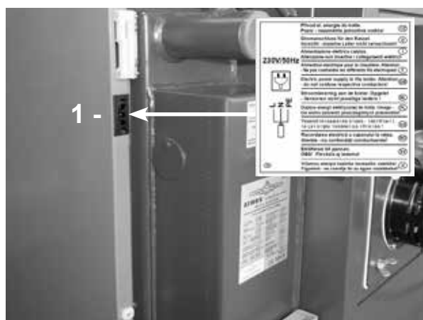
Connecteur sur la chaudière hotte droit
